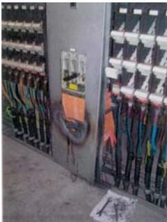
**Bild:** Durch das unsachgemäße Arbeiten in der Nähe unter Spannung stehender Teile wurde ein Lichtbogen verursacht.
